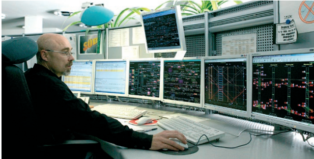
Abbildung 3: Netzleitzentrale in Frankfurt(M). Foto: DB AG/Vedder
