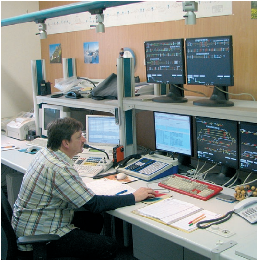
Abbildung 13 a: Elektronisches Stellwerk Bf Montabaur, Strecke Köln – Frankfurt (M).
