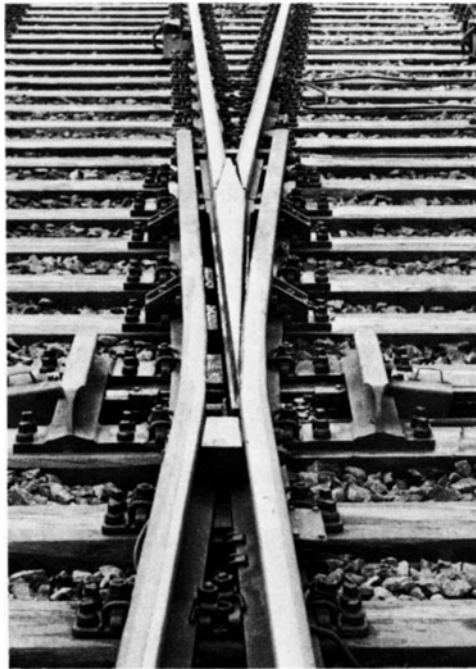
Bild 6 Weiche mit beweglichem Herzstück
