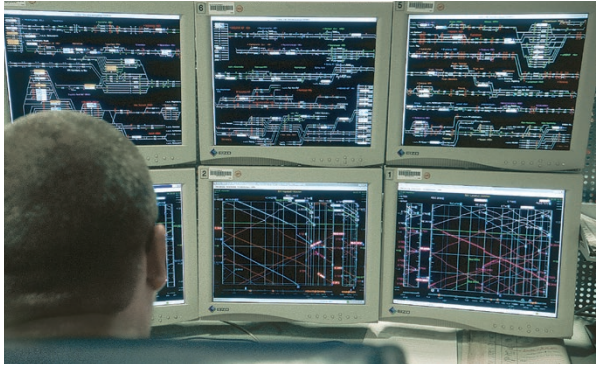
Abb. 1-3: Arbeitsplatz des Fahrdienstleiters Ingolstadt in der Betriebszentrale München Foto: DB AG/Schmid
