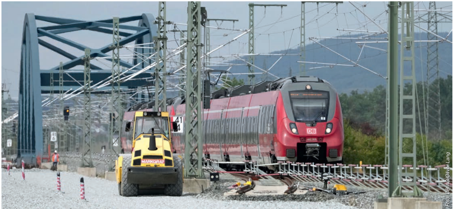
Bauarbeiten an der geplanten Hochleistungstrasse auf der Ausbaustrecke Nürnberg–Ehrensfeld
