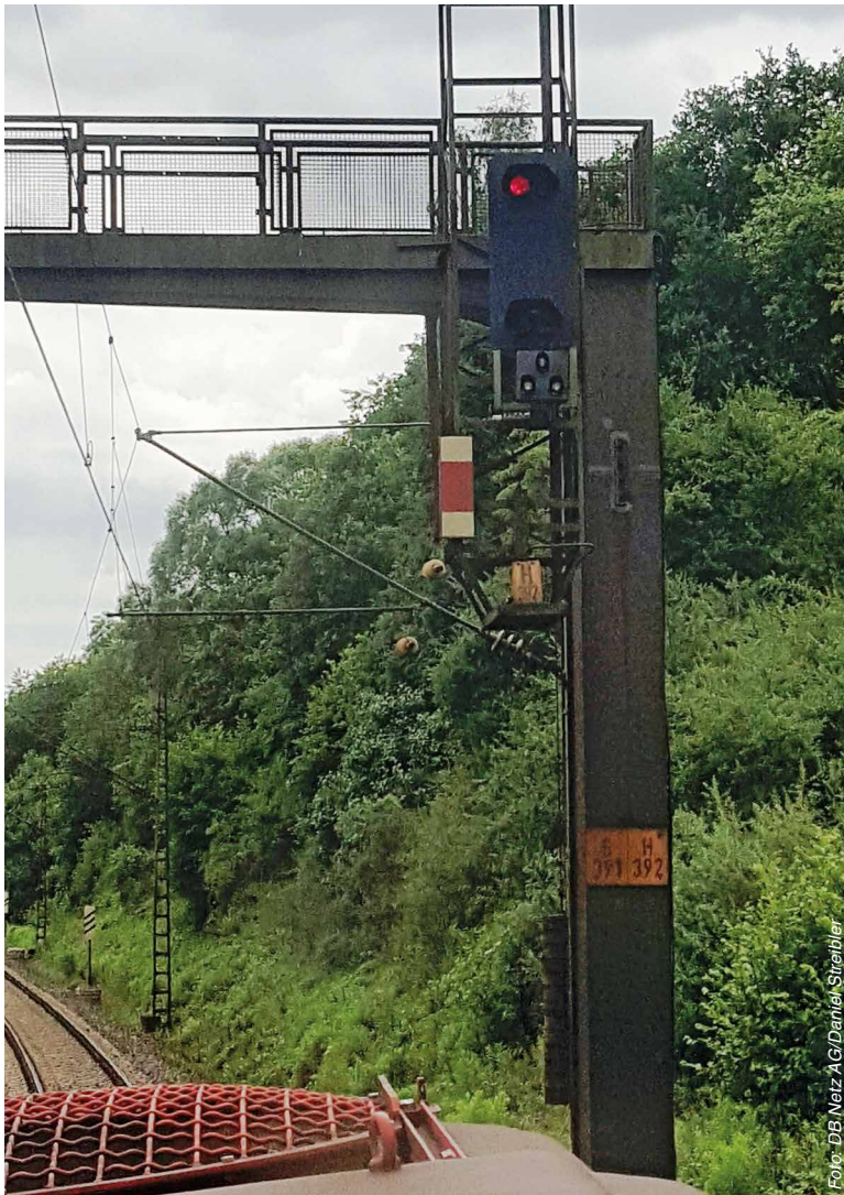
Lichthauptsignal H 392 zwischen Bebra und Corn- berg in Haltestel- lung mit Signal Zs 1
