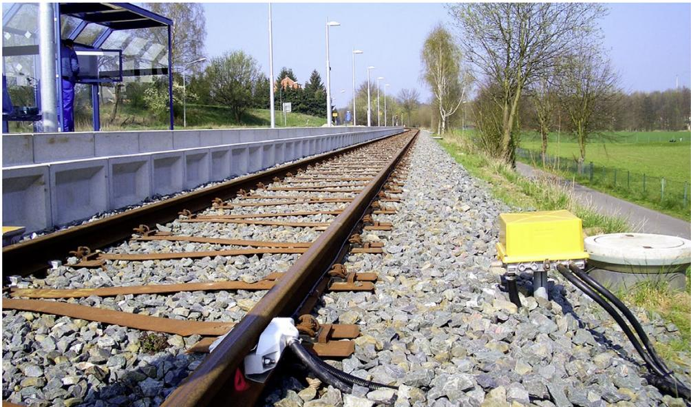
Abb. 5-4: Achszählkontakt am Gleis
