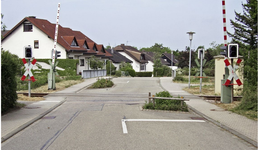
Abb. 1-2: Beispiel für unzureichend abgestimmte Maßnahmen am Bahnübergang
